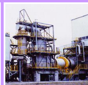
上海・浦東国際空港焼却炉
