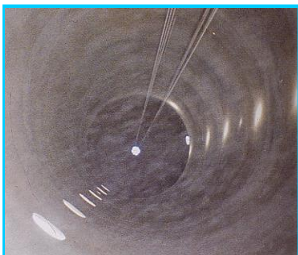
不定形耐火物施工
