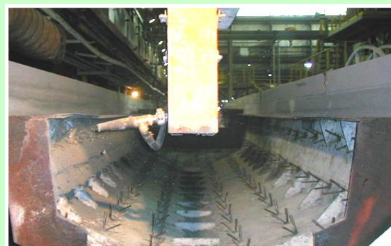
オフライン吹付補修
