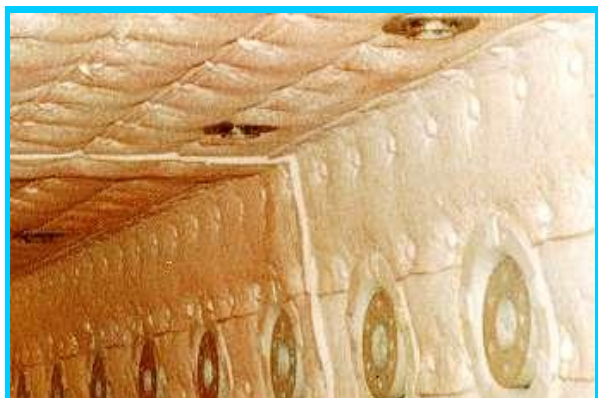
セラミックファイバー施工
